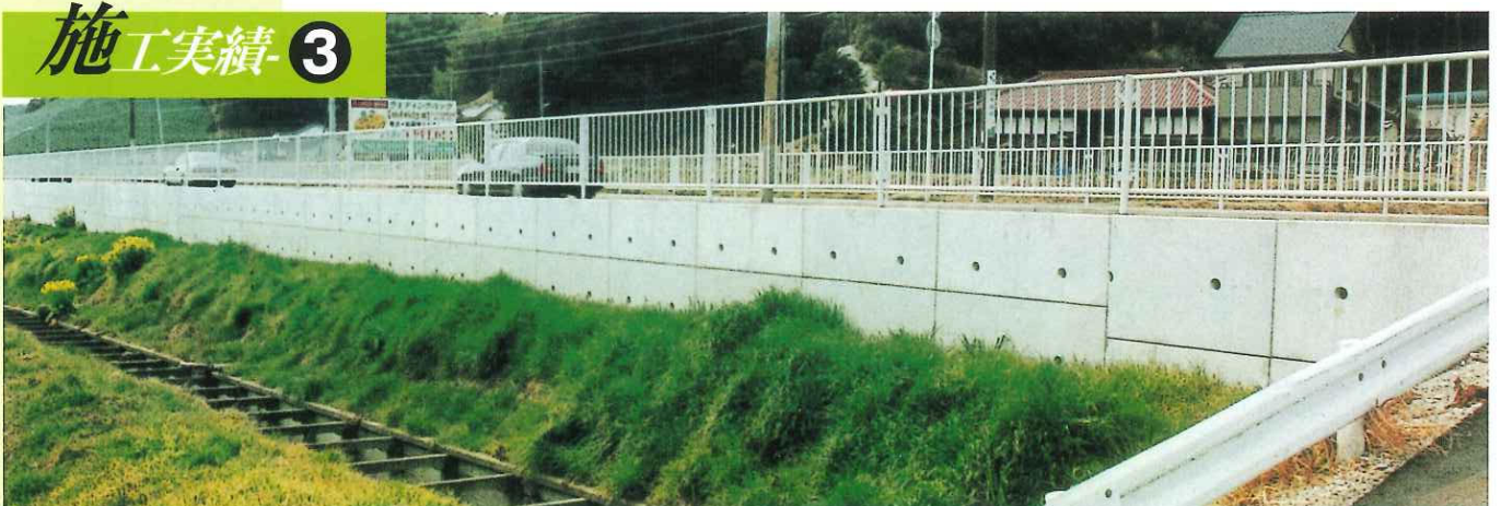
国道への施工例(千葉県富津市亀沢字北上「国道127号線」)
