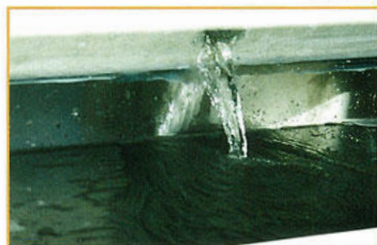
散水の排出状況
