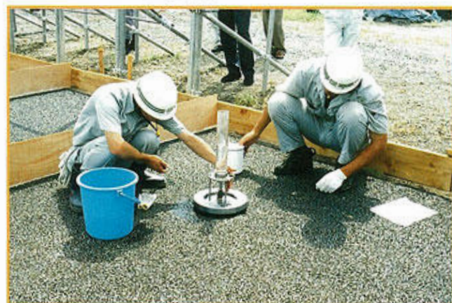
現場透水試験の状況
