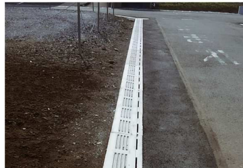
写真はサイクル側溝乗入部
