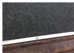
④プレートとボルトにてシートを固定
