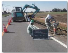
②基礎転圧
