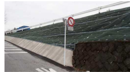
急な斜面で除草作業が困難な現場
