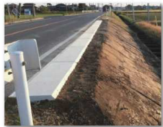
④法面整形
