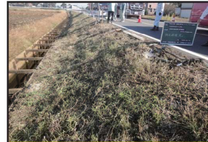
杉戸県土管内施工前
