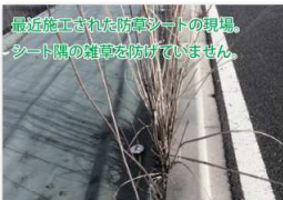
しっかりとした工法で施工しないと 隙間から雑草が曲てきます。
