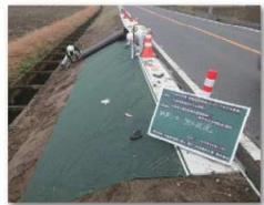
⑤防草シート施工
