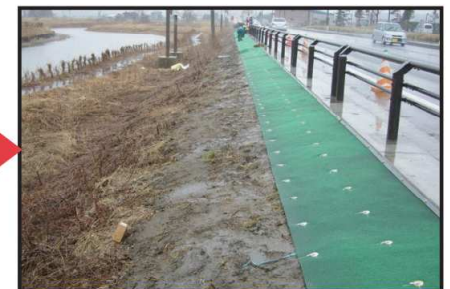
シート固定により 劣化を防いだ現場
