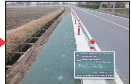
杉戸県土管内施工後
