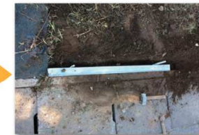
②保持ブロックを側溝脇に設置、 アンカーにて固定
