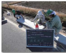
③ロードキーパー設置
