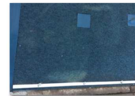
③シート設置し、プレート・ボルト、 アンカーピンにて固定
