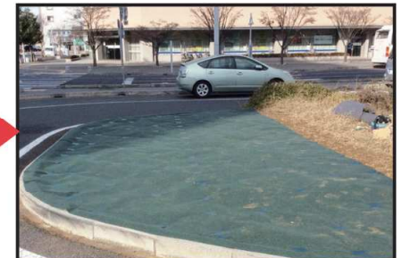
つくばエクスプレス 駅前ロータリー施工後
