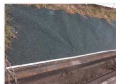
⑤アンカーピンにてシートを固定
