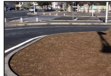
つくばエクスプレス 駅前ロータリー施工前
